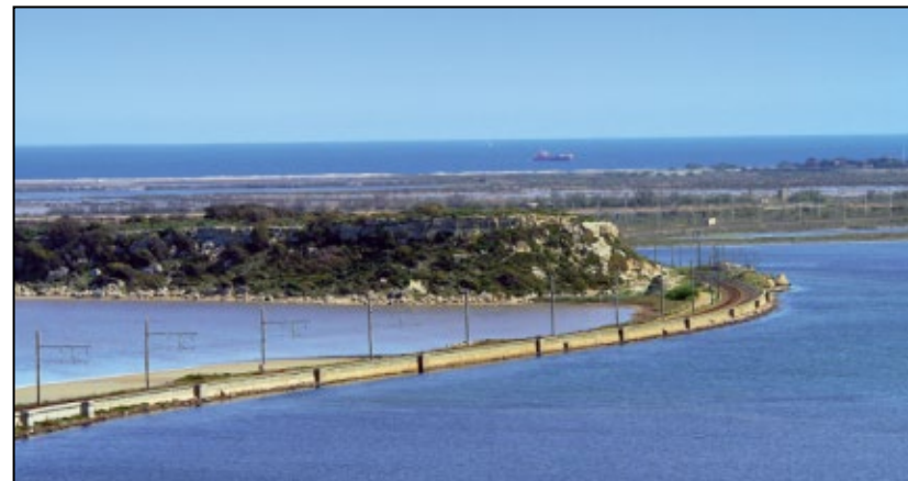
Figure 84 : Traversée de l'étang de Bages – Sigean par la ligne existante
