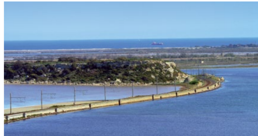
Figure 59 : Traversée de l'étang de Bages – Sigean par la ligne existante
