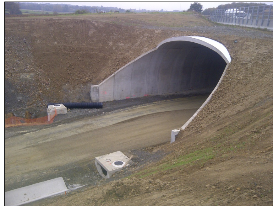
Figure 29 : Tranchée couverte en construction
