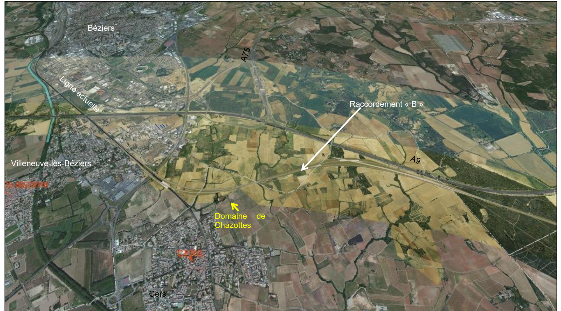
Figure 14 : Amorce de la LNMP à l'est de Béziers – Raccordement « B » (source : SNCF Réseau)
