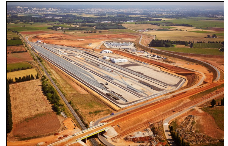
Figure 30 : Double base travaux du Contournement de Nîmes et Montpellier (source : Oc'Via)
