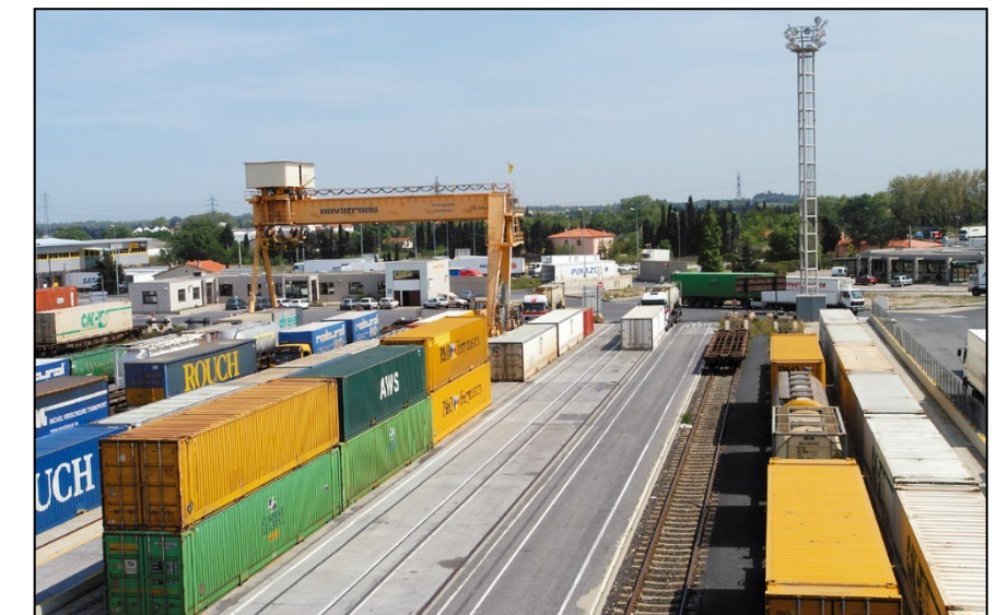
Figure 88 : Plateforme de transport combiné de Perpignan (source : Réseau)
