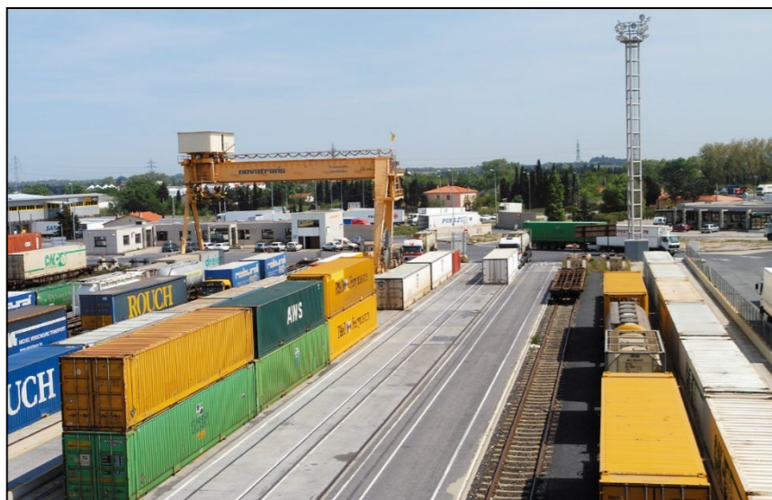
Figure 61 : Plateforme de transport combiné de Perpignan (source : SNCF Réseau)
