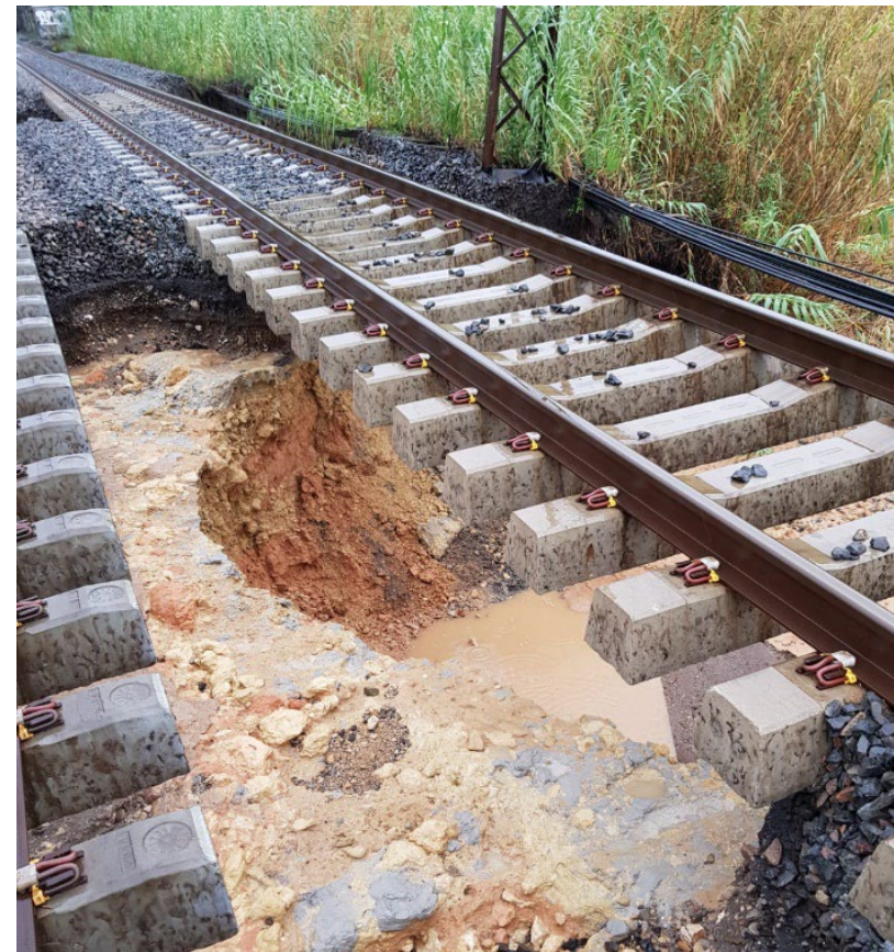
Figure 71 : Dégâts causés par les inondations d'octobre 2019 (source : SNCF Réseau)
