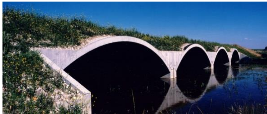
Figure 116 - Photo d'ouvrage multi-voute sous autoroute (source : INGEROP)
