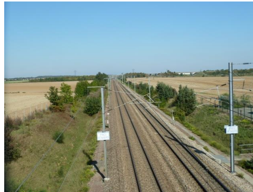
Figure 127 - Caténares sur LGV à double voie (source : SNCF Réseau)
