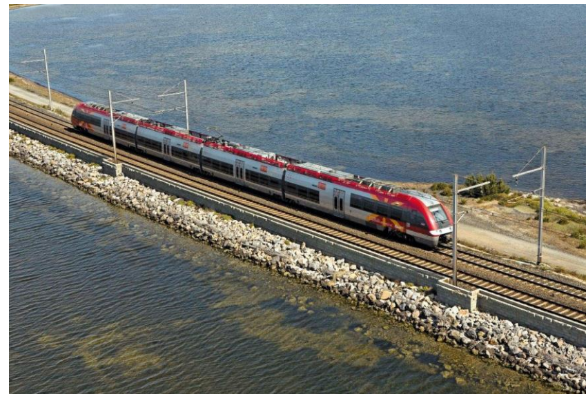
Figure 12 - TER en Languedoc-Roussillon (source : SNCF Réseau)
