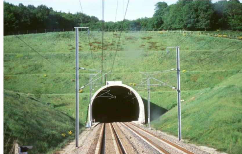
Figure 80 - Tunnel sur LGV Rhin-Rhône (source : SNCF Réseau)
