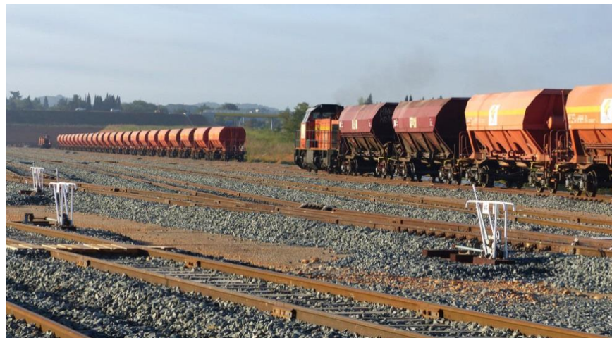
Figure 135 - Trains de ballast sur la base travaux de CNM (source : Oc'Via)
