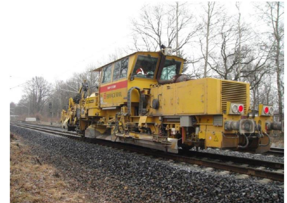
Figure 22 - Travaux de maintenance (source : SNCF Réseau)
