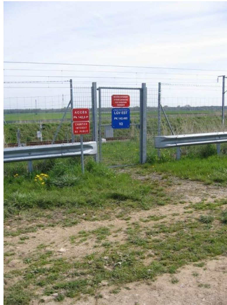
Figure 132 - Portail d'accès piétons (source : SNCF Réseau)
