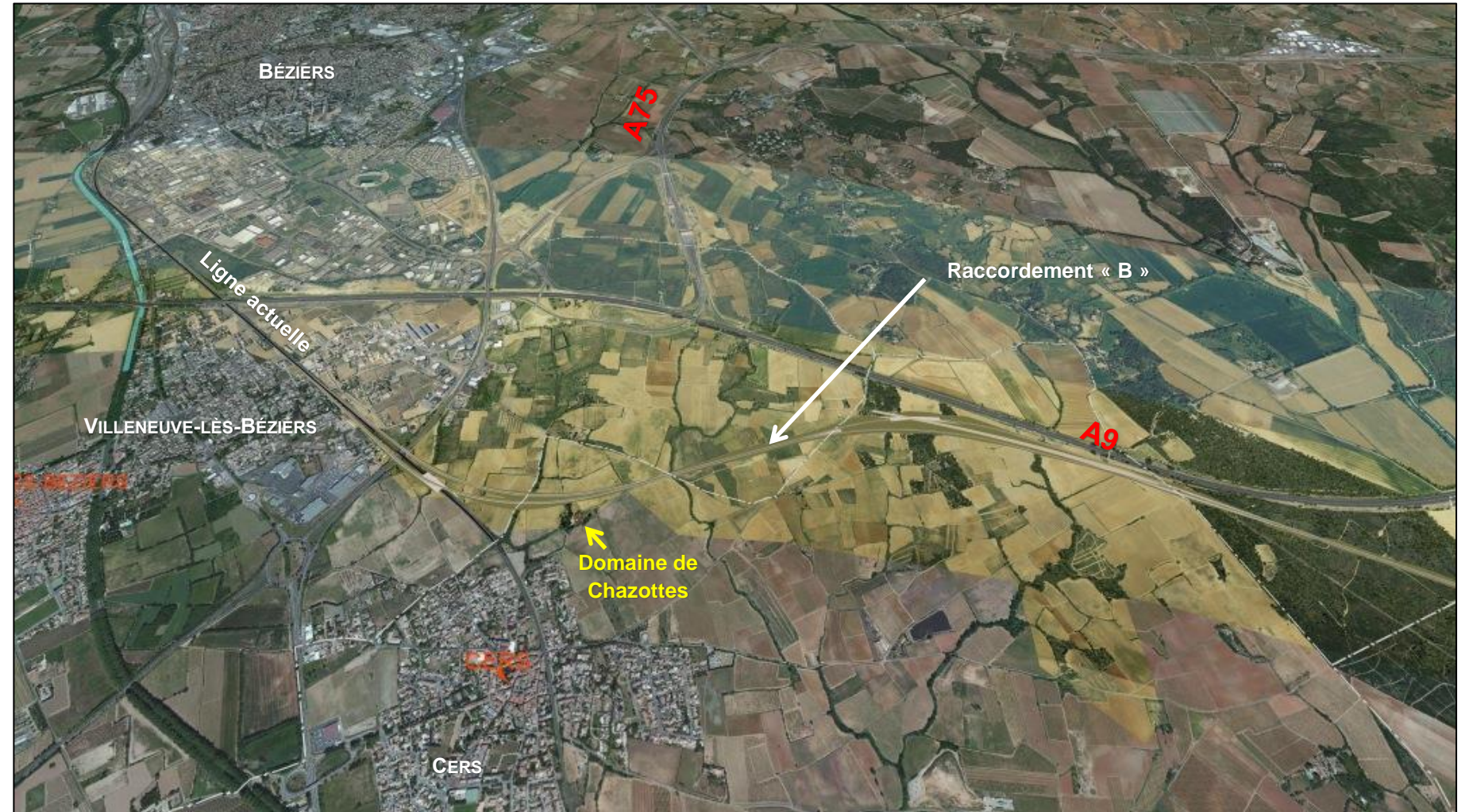
Figure 27 : Amorce de la LNMP à l'est de Béziers – Raccordement « B » (source : SNCF Réseau)
