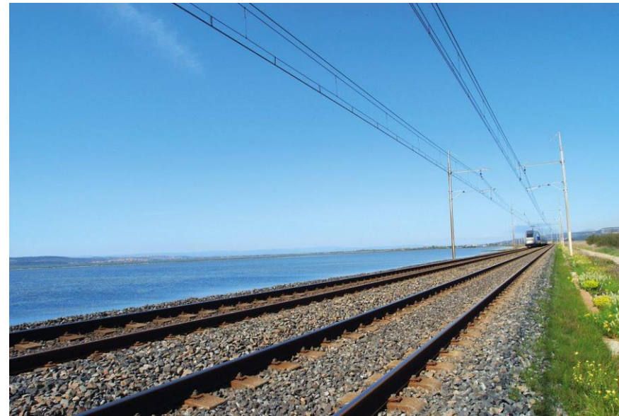
Figure 4 - Voie ferrée existante entre Montpellier et Béziers (source : SNCF Réseau)
