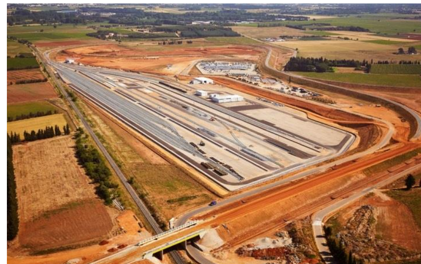
Figure 93 - Double base travaux du Contournement de Nîmes et Montpellier (source : Oc'Via)
