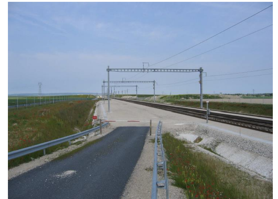
Figure 133 - Aire de montage d'appareils de voie (source : SNCF Réseau)
