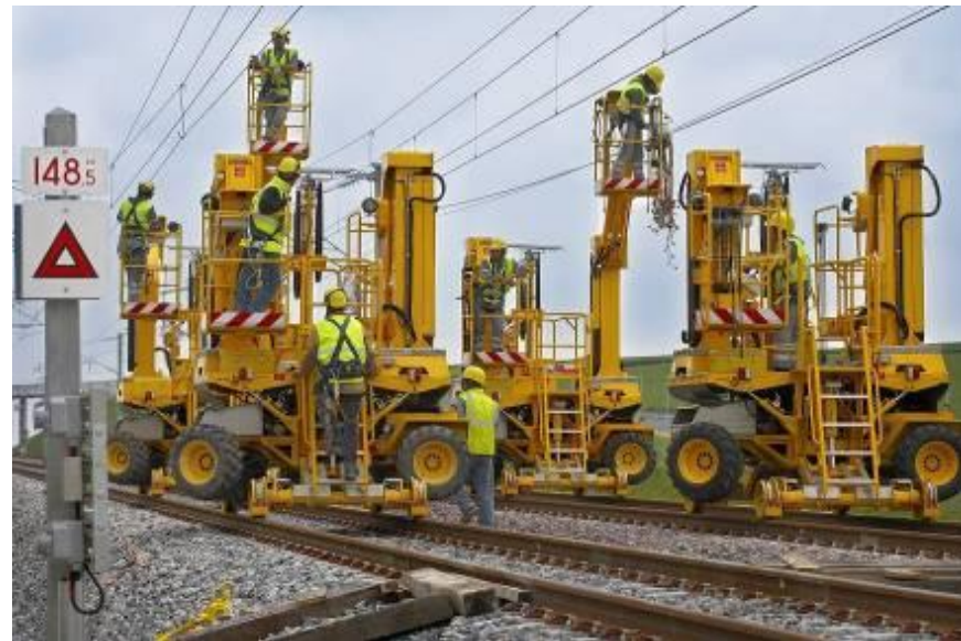
Figure 129 - Pose de caténaire sur LGV (source : SNCF Réseau)
