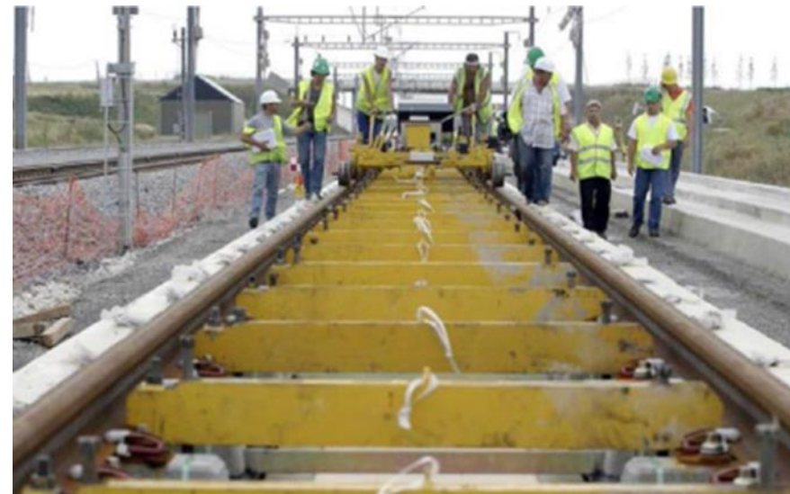
Figure 136 - La mise en place des voies (source : SNCF Réseau)
