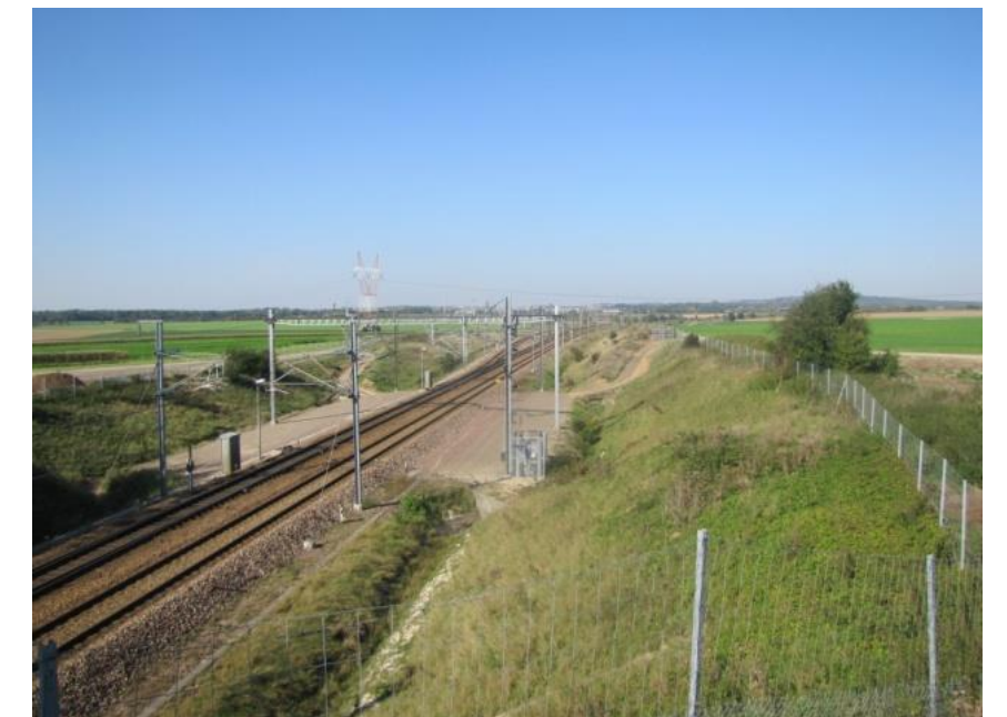
Figure 130 - Clôture et accès à la plateforme (source : SNCF Réseau)
