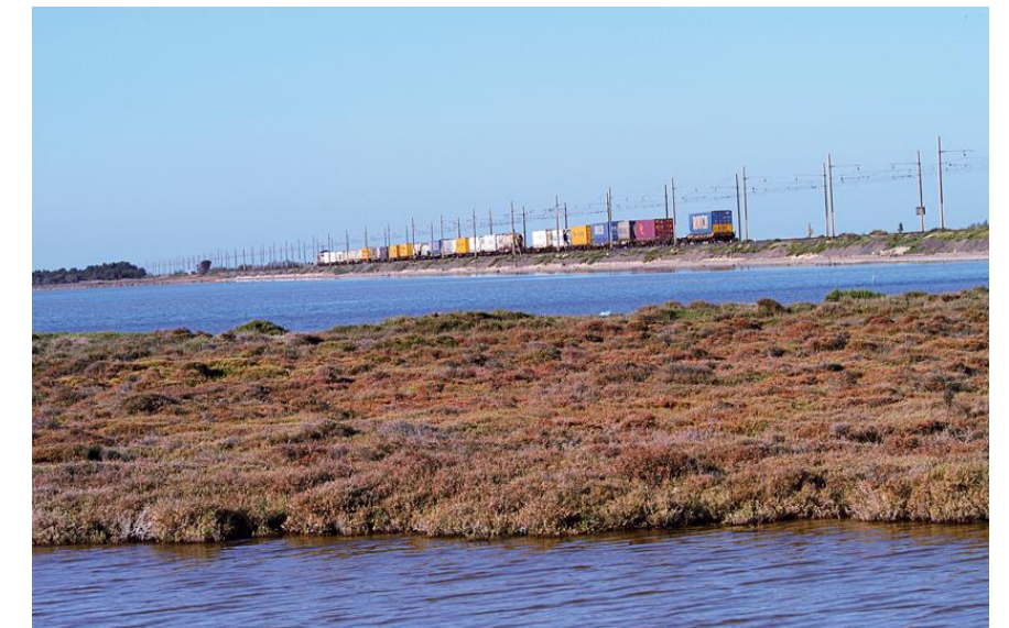
Figure 13 – Train de fret dans la traversée des étangs littoraux (source : SNCF Réseau)
