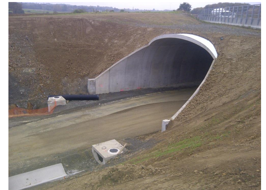
Figure 81 - Tranchée couverte en construction (source : INGEROP)
