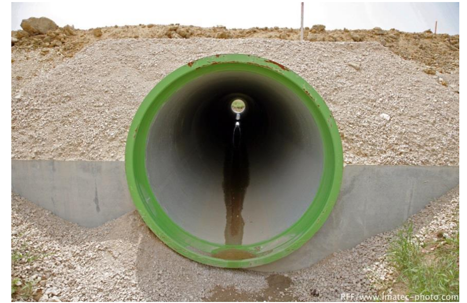
Figure 118 - Buse béton Type (source : SNCF Réseau)
