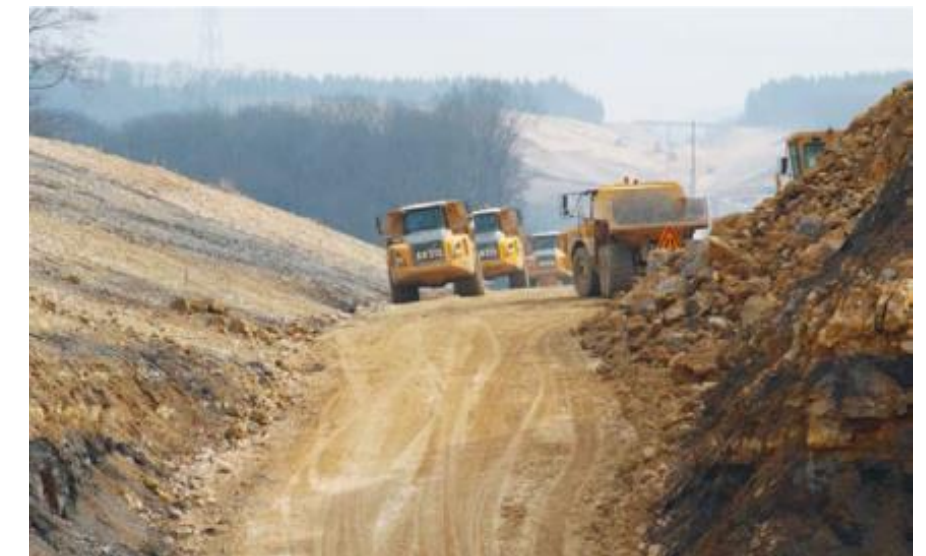
Figure 134 - Travaux de génie civil : terrassements (source : SNCF Réseau)
