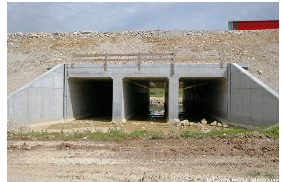
Figure 119 - Dalot Type (source : SNCF Réseau)
