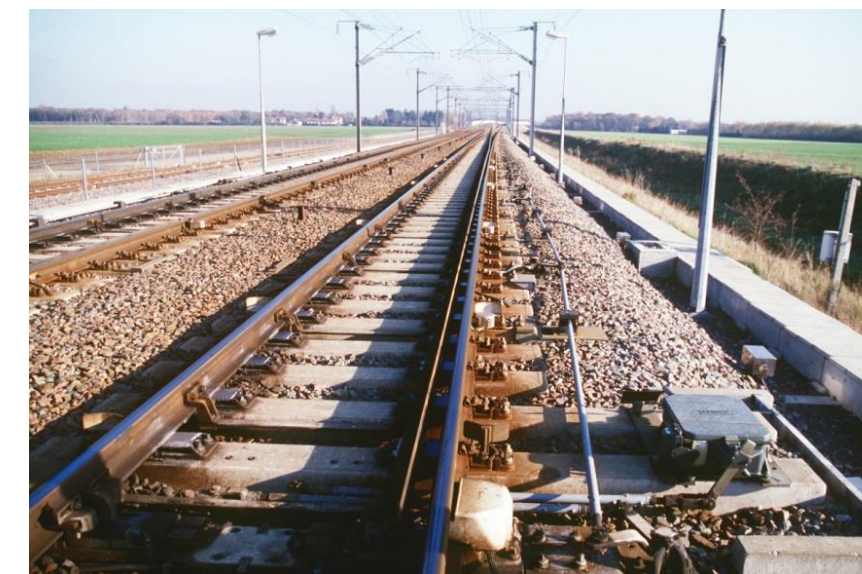
Figure 122 - Appareil de voie franchissable à 230 km/h (source : SNCF Réseau)
