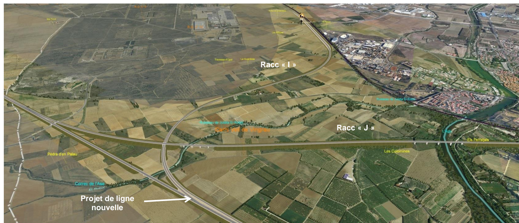
Figure 44 : LNMP et les raccordements I et J, au centre le camp Joffre (source : SNCF Réseau)
