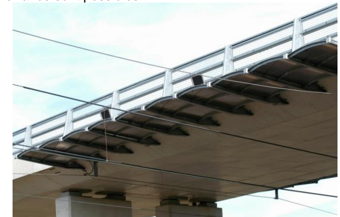
Figure 68 - Auvent de protection caténaire horizontale (source : SNCF Réseau)
