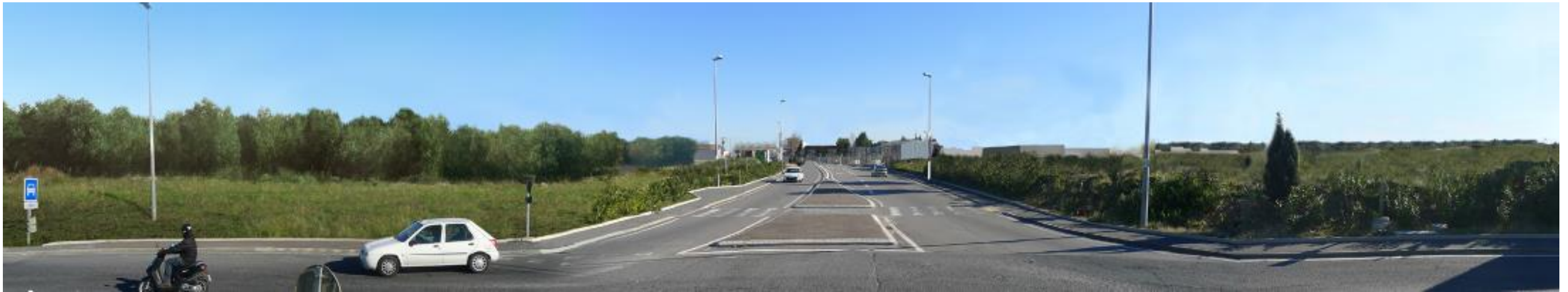
Figure 36 : photomontage de la traversée du Soler depuis la RD916 - rond-point de la Méditerranée (source : Traverses)
