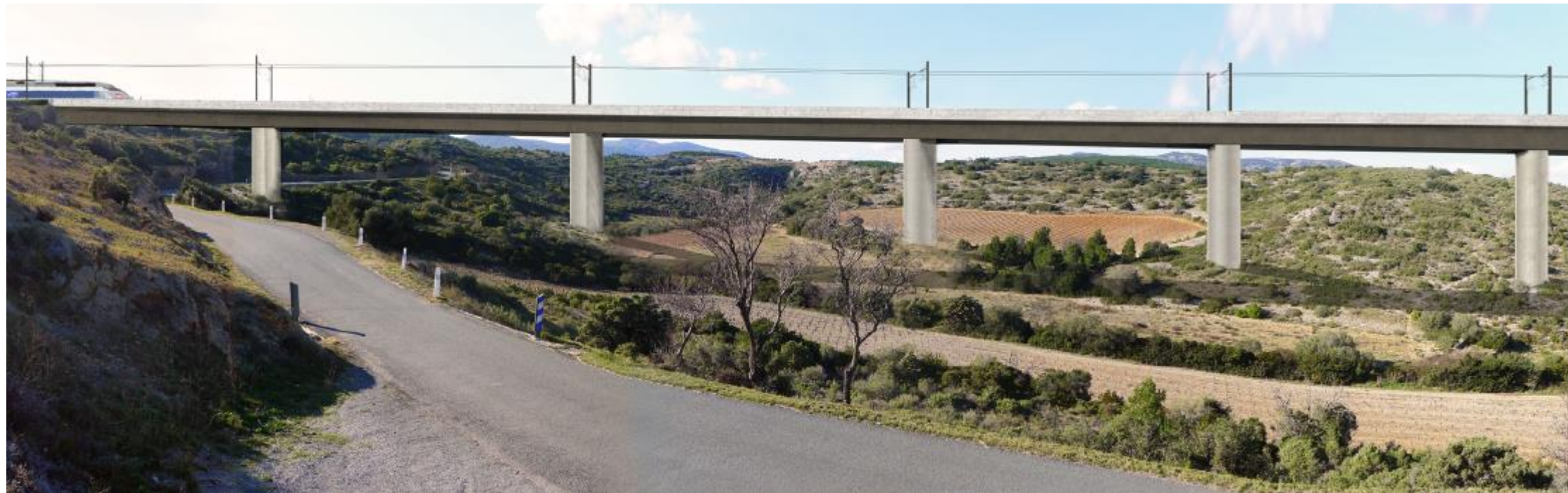
Figure 54 : photomontage du viaduc de l'Arène depuis la RD27 à Treilles – vue prévisionnelle indicative (source : Ingerop)
