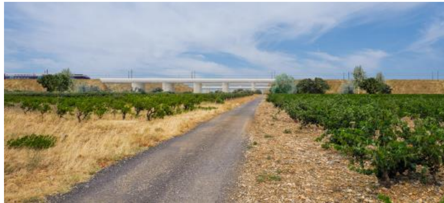
Figure 44 : photomontage de la Ligne Nouvelle et de ses raccordements dans la plaine alluviale du Roboul, à Rivesaltes – vue prévisionnelle indicative (source : Ingerop)
