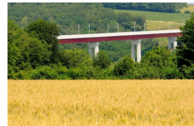
Figure 5 : Principe de développement attendu de la végétation sous les viaducs (source : SNCF Réseau)
