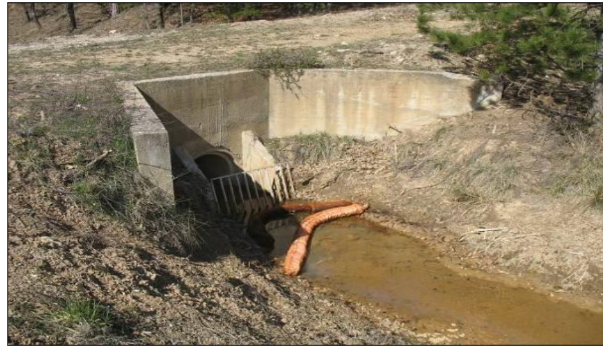
Figure 9 : Exemple d'utilisation d'un boudin dédié à l'absorption des hydrocarbures (source : J. BAILLEAU, ECOMED)
