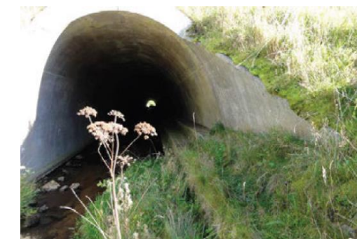
Figure 19 : Ouvrage aménagé sur un côté pour le passage de la faune semi-aquatique
