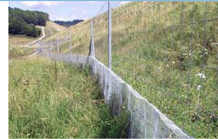
Figure 25 : Clôture à maille fine, évitant l'accès aux amphibiens (source : SNCF Réseau)
