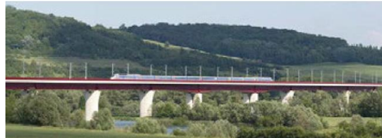
Figure 20 : Viaduc, enjambant le lit mineur (source : Egis)
