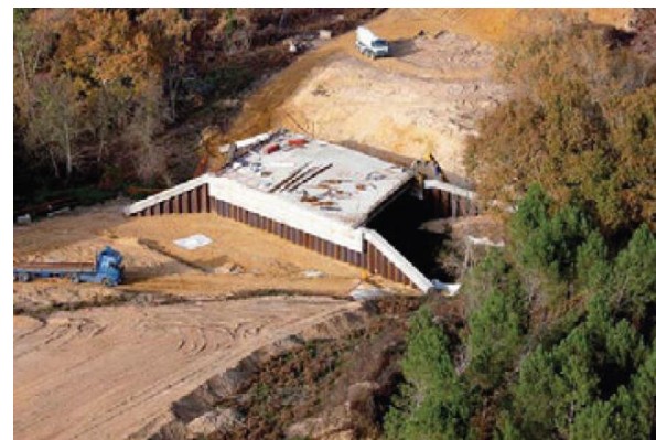
Figure 21 : Mise en place d'un ouvrage de type portique (source : Egis)
