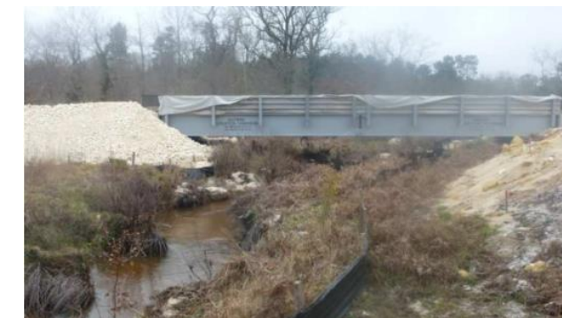
Figure 13 : Ouvrage de franchissement provisoire sans assise en lit mineur (source : LGV Sud Europe Atlantique, Onema)
