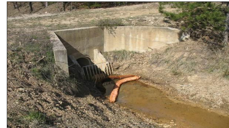
Figure 9 : Exemple d'utilisation d'un boudin dédié à l'absorption des hydrocarbures (source : J. BAILLEAU, ECOMED)
