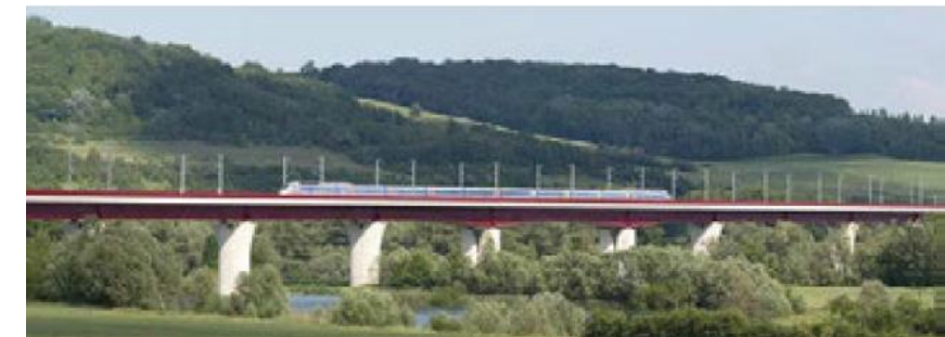
Figure 21 : Viaduc, enjambant le lit mineur (source : Egis)
