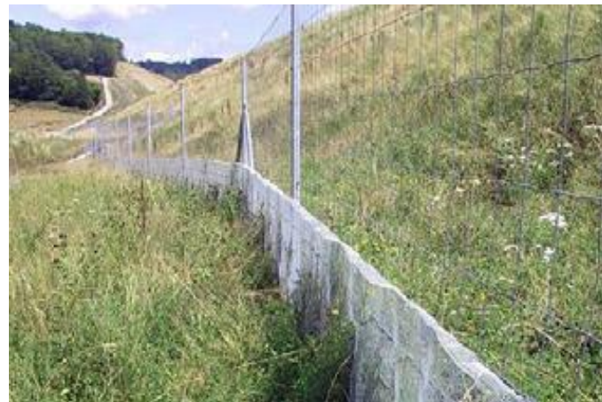
Figure 26 : Clôture à maille fine, évitant l'accès aux amphibiens (source : SNCF Réseau)
