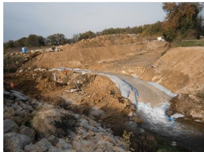
Figure 14 : Détournement de la Basse (66) lors du chantier de création de la Ligne Electrique France – Espagne, RTE (source : ECOMED, 2013)
