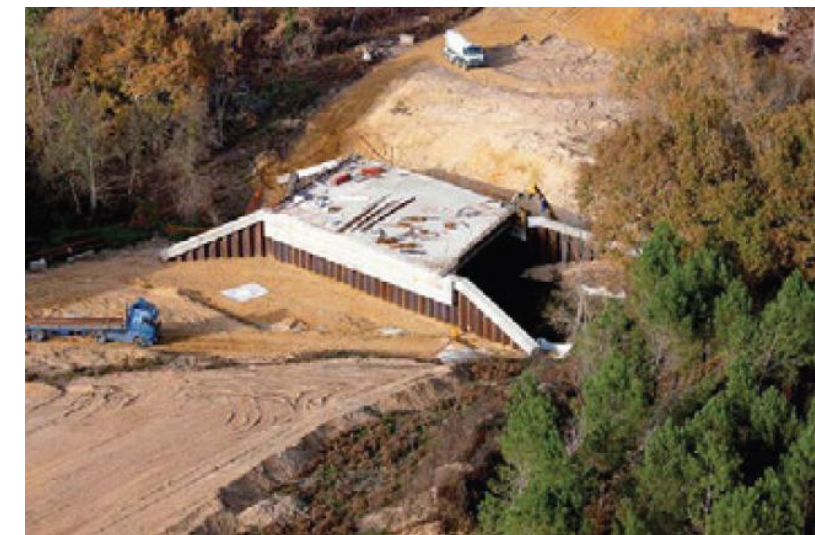
Figure 22 : Mise en place d'un ouvrage de type portique (source : Egis)
